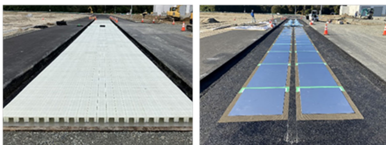
写真-2 施工状況（左：雨水浸透材 右：送電電極）
