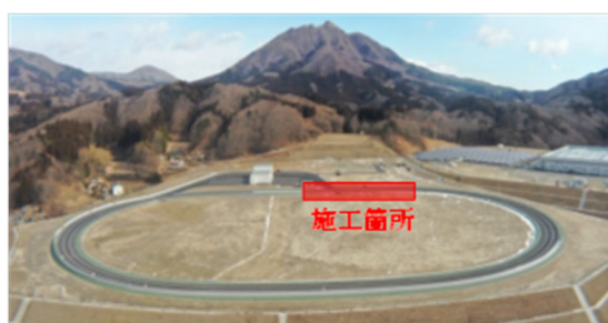
写真-1 耐久性評価フィールド施工箇所
