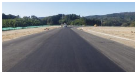
写真-2 施工後全景
