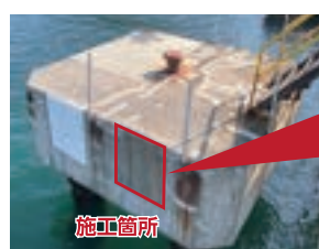
塗膜が透明なので、コンクリート表面の様子がよくわかります
