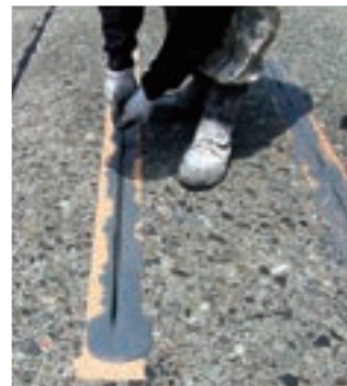
〈フラットバー挿入状況〉
