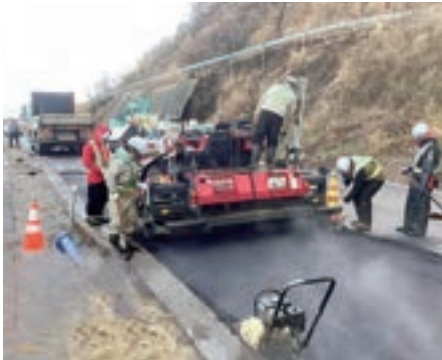
舗装打替え工 表層敷均し
