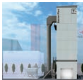
コンクリートプラント 製造能力: 78m 3 /h
