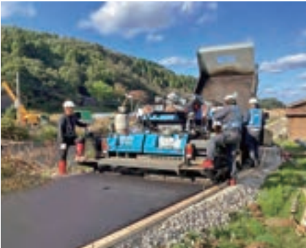
舗装打替え工 表層敷均し
