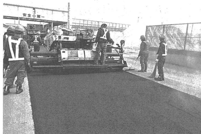
環境配慮型の道路舗装材料を使って試験的に施工する様子 ―宮城県石巻市（大成ロテック提供）―
